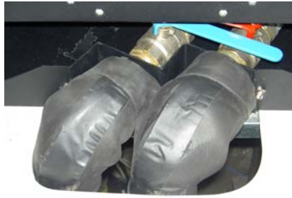
Figure 3. Connexion avec les raccords coudés
