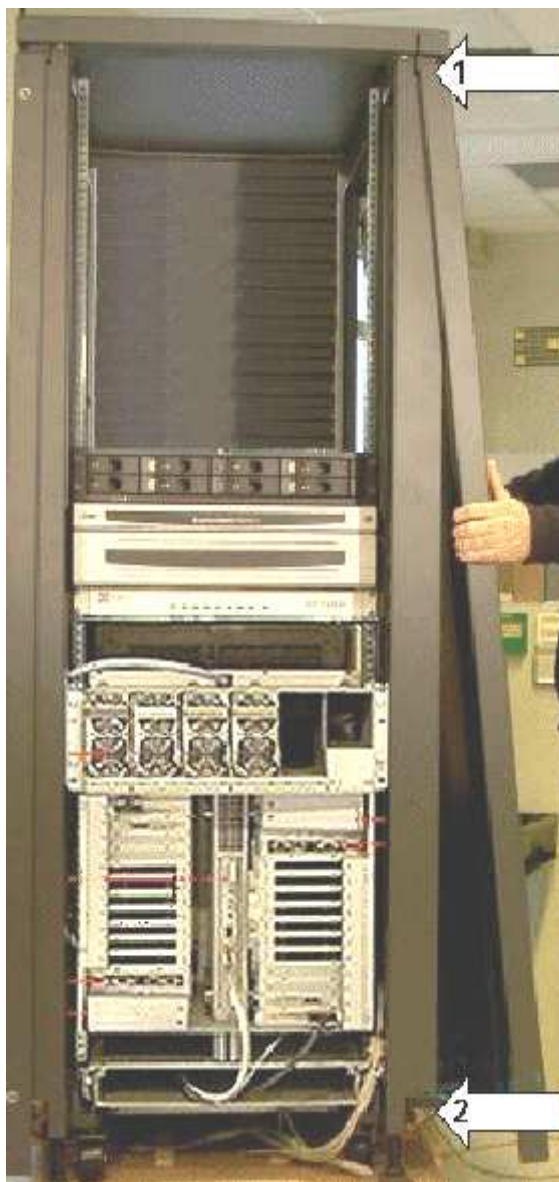
Figure 22. Remontage des panneaux latéraux
