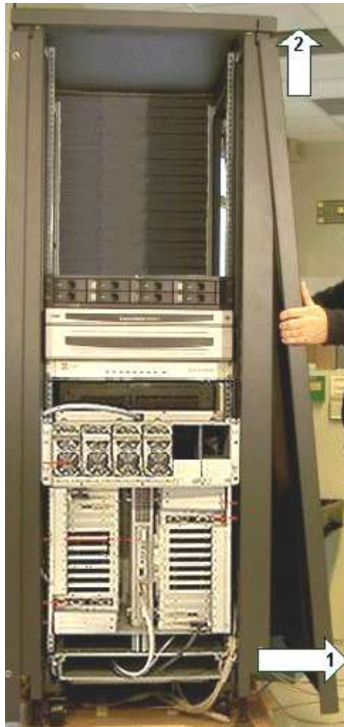
Figure 21. Démontage des panneaux latéraux
