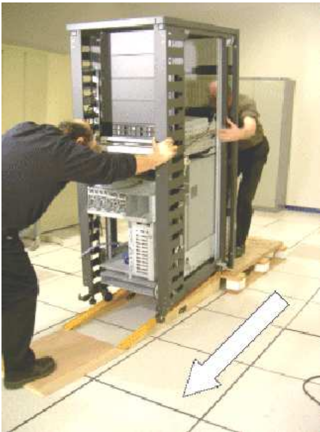
Figure 11. Déchargement de l'armoire
