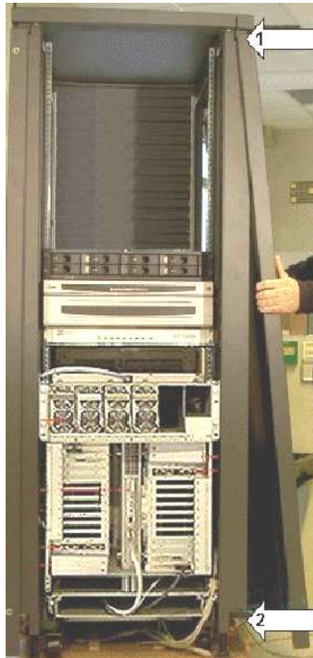
Figure 22. Remontage des panneaux latéraux – Armoire 36U
