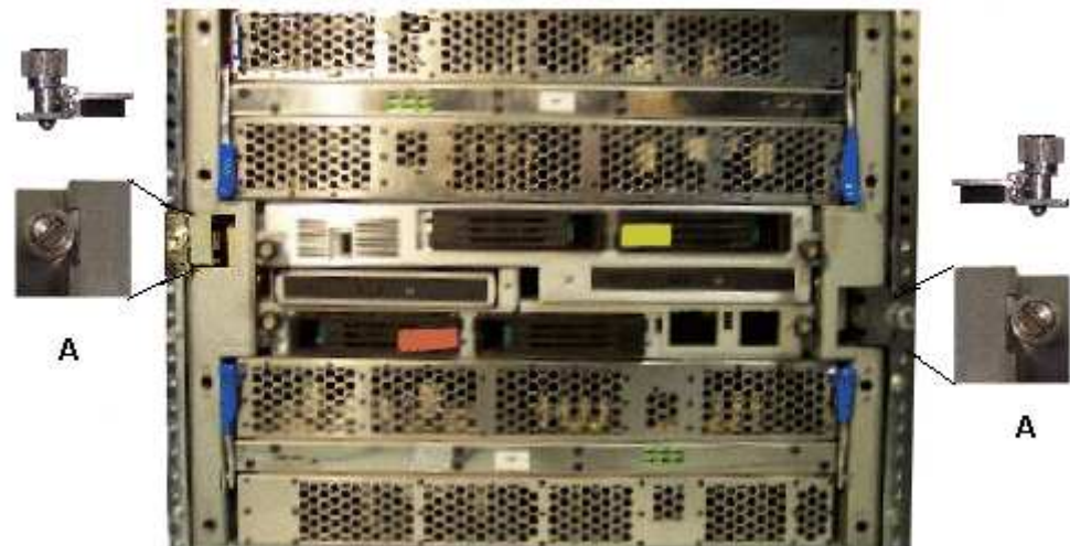
Figure 4. Installation des butées avant
