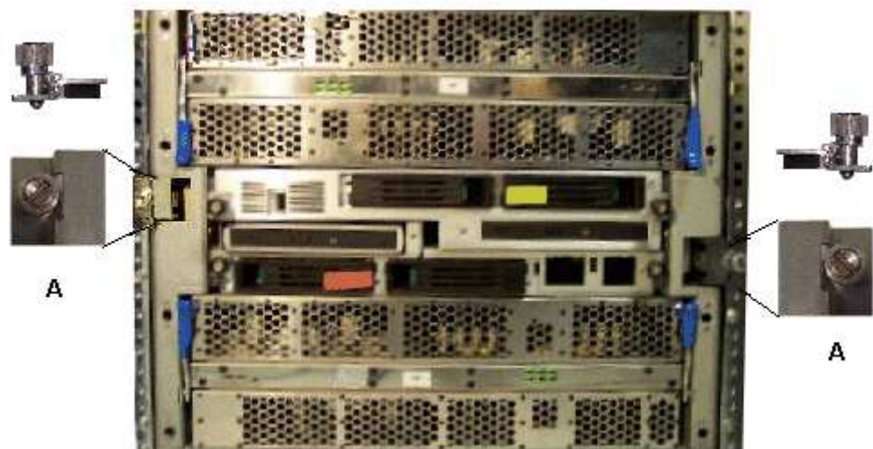
Figure 4. Installation des butées avant
