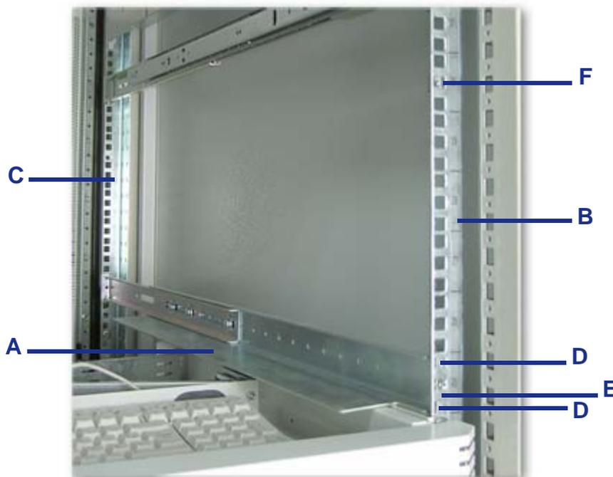
*Figure 29: Installation du rail de support droit*
